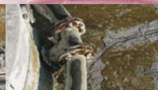
Korrodierte Zuleitungsröhre
