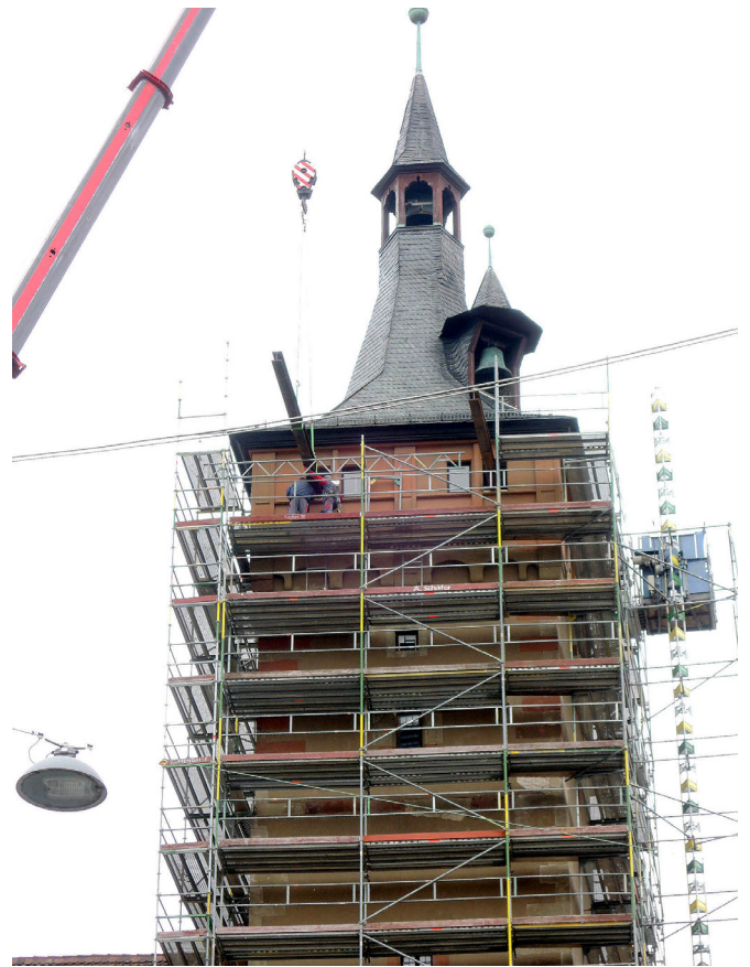
Das Gerüst muss nicht nur die über 800 Kilogramm schwere staubsichere Plane tragen, sondern bietet den Handwerkern den Zugang zu ihrer Arbeitsplatz am Baudenkmal Grafeneckart.
