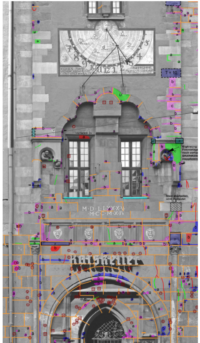
Im Rahmen der Voruntersuchungen zu Beginn des Jahres 2016 wurde der Bestand von Natursteinen, Verputzen und Anstrichresten aufgenommen und für jedes Bauteil kartiert. Diese Abbildung zeigt eine solche Kartierung. Sie war Basis für den Maßnahmenkatalog zur Sanierung.
