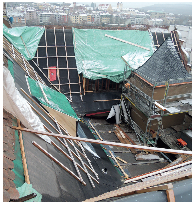
Einblicke in die Dachsanierung. Nur mit einem zweiten speziellen Hängegerüst konnten Türmerstube und Turmspitze abgestützt und das Dach erneuert werden. Die Steil- und Flachdächer wurden dabei gleich energetisch saniert.
