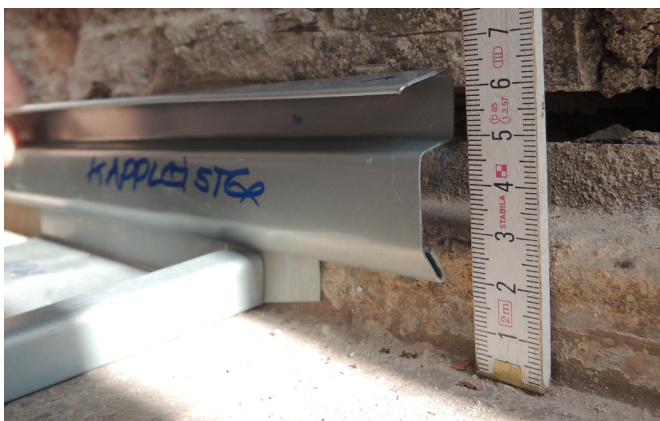
Ein Muster der Schutzverblechung der Gesimse.
