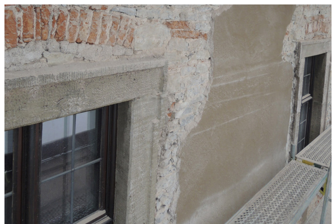
Abgeplatzte Putzstellen wurden erneuert.
