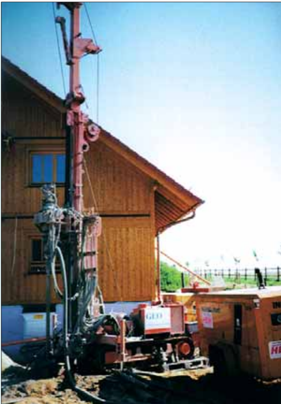
Erstellung einer Erdwärmesonde für ein Einfamilienhaus
