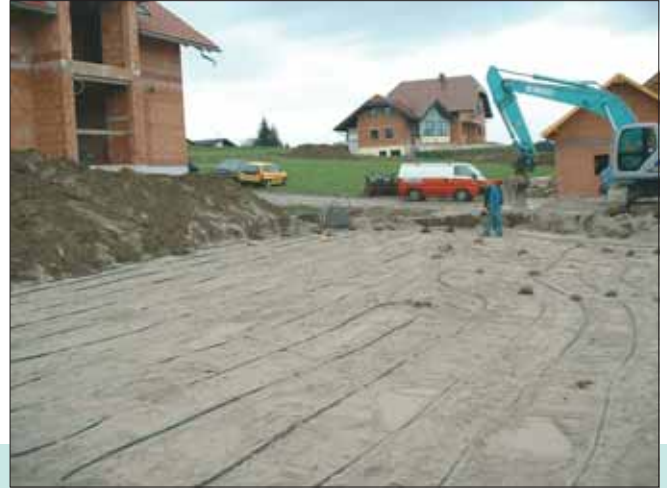
Verlegung eines Erdwärmekollektors Quelle: Vaillant
