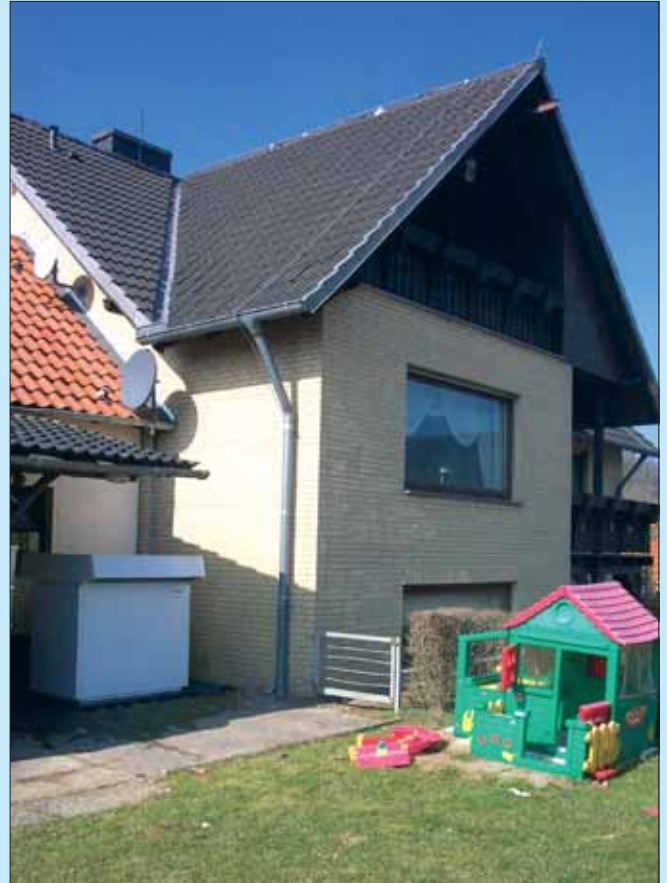
Gartenansicht mit Wärmepumpe Quelle: Stiebel Eltron
