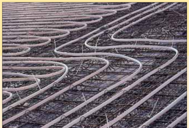
Grafik Hoffmann Kontor in Kleve (oben), Seitenansicht des Gebäudes (Mitte) und Rohrsystem zur Betonkerntemperierung (unten) Fotos/Grafik: Repp GmbH
