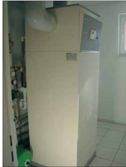
Abluftgerät als Luft / Wasser-Wärmepumpe mit integriertem Warm- wasserspeicher Quelle: Stiebel Eltron
