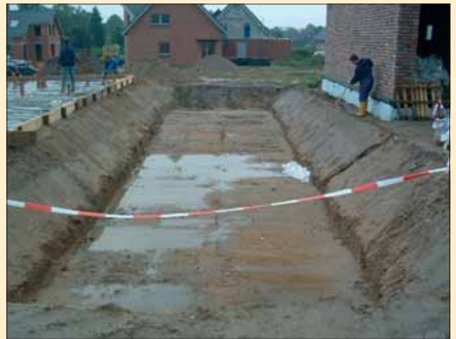
Baugrube zur Aufnahme des Erdkollektors Foto: Schwalger, Goch
