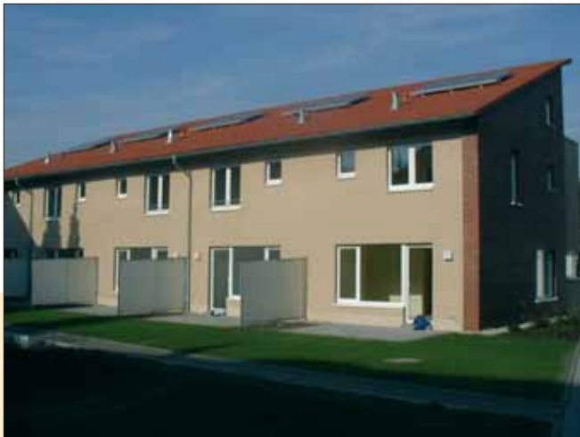
8 Reihenhäuser als Niedrigenergiehäuser Quelle: Stiebel Eltron
