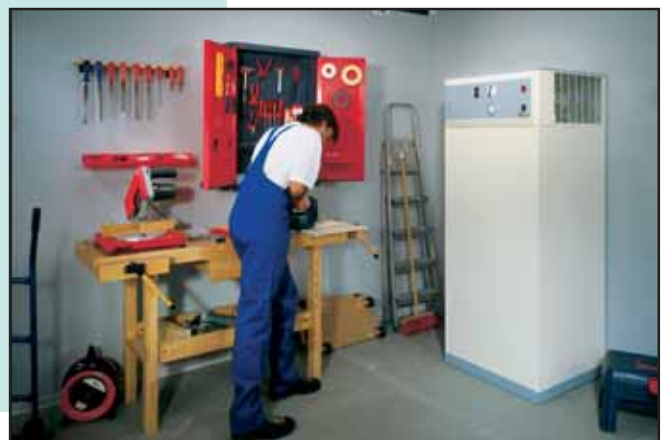
Installierte Brauchwasser-Wärmepumpe Foto: tecalor
