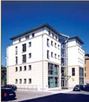
Straßenansicht des Wohn- und Geschäftshauses Foto: Kamieth
