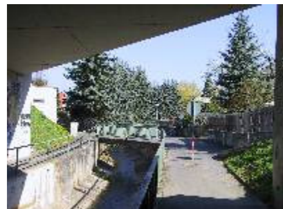
Der Zwischengemäuerbach oder besser zwischen Beton Bach ?
