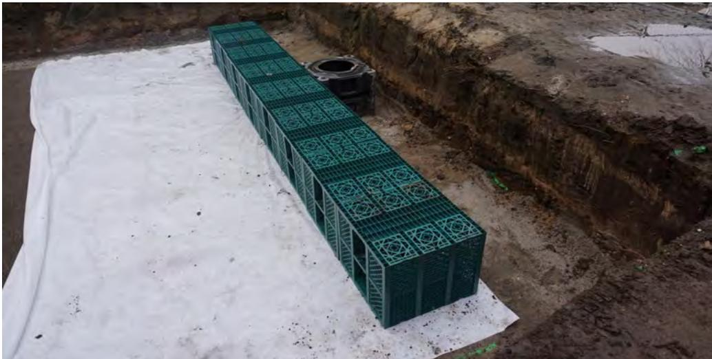
Abb. 43: Rigolelemente in Form von Kunststofffüllkörpern beim Einbau
