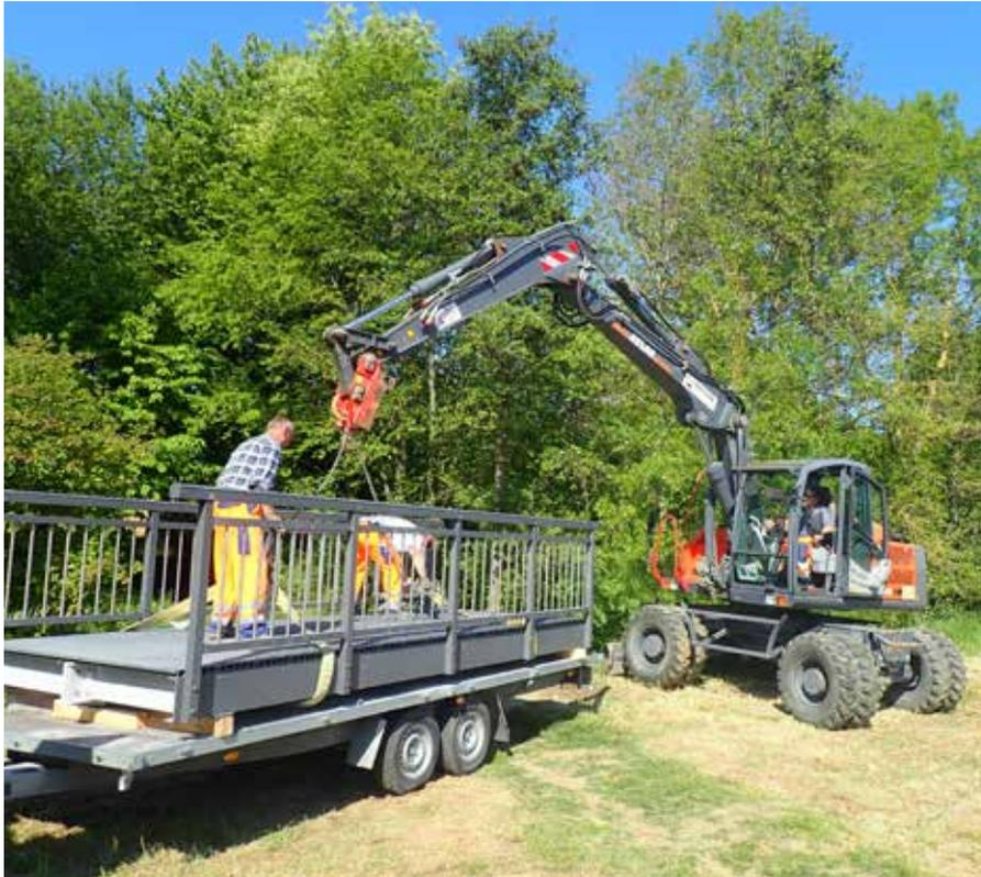
unmöglich und es lässt sich schnell und kostengünstig montieren. Vorgefertigt im Werk wurde die Brücke in nur einem Tag mit einem Bagger auf die bestehenden Widerlager gesetzt. Die Betonkonstruktion der alten Holzbrücke konnte unverändert weiter genutzt werden. Die Arbeiten rund um die Brücke tätigte der Brückentrupp des städtischen Bauhofs.
