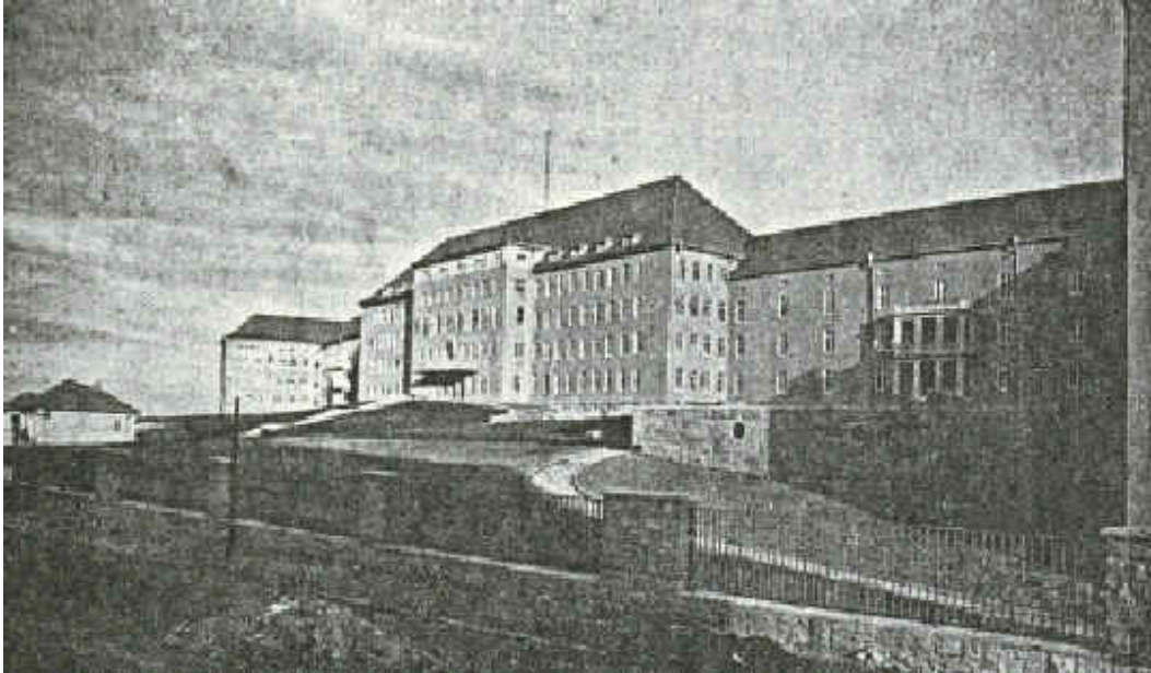
1. Ein Photo der Jahres 1938 verdeutlicht deutlicher als der heutige Bauzustand und die Flora im Gelände die Brutalität und Monumentalität des Gebäudes.
