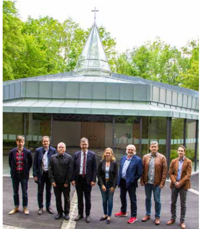
Neue Aussegnungshalle mit neuen räumlichen Kapazitäten: Michael Altmann, Fachbereichsleitung Hochbau, Baureferent Benjamin Schneider, Kommunalreferent Wolfgang Kleiner, Oberbürgermeister Christian Schuchardt, Bürgermeisterin Judith Roth-Jörg, Projektinitiator Stadtrat Josef Hofmann, Tobias Furth, Projektleitung Hochbau, und der Leiter der Friedhofsverwaltung Christian Götzelmann beim Ortstermin auf dem Versbacher Friedhof.
