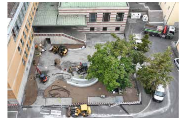
Drohnenaufnahme während der Bauarbeiten. Foto: FA Geodaten und Vermessung / Drohnenaufnahme
