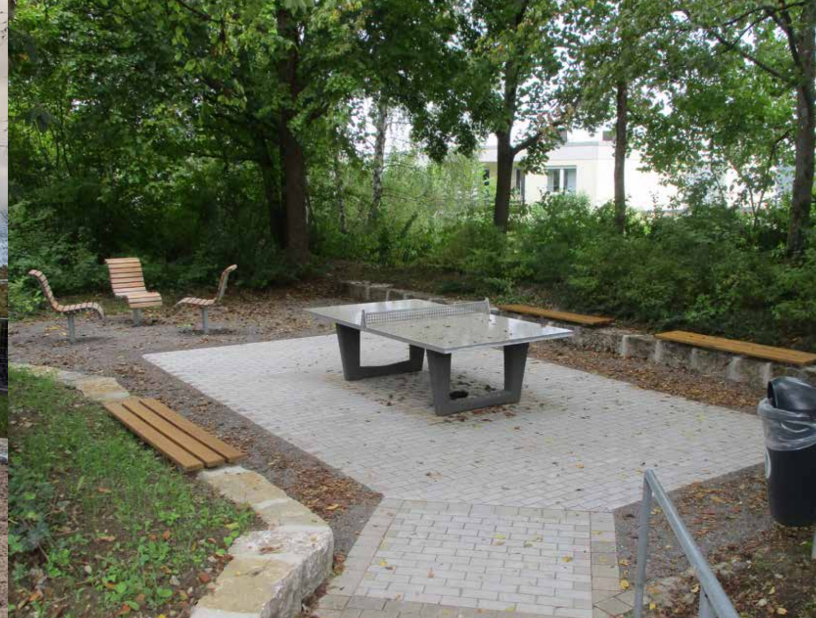
Beim Spielplatz in der Frankenstraße wurde der Bodenbelag saniert, die Tischtennisplatte ersetzt und eine neue, jugendgerechte Möblierung aufgebaut.
