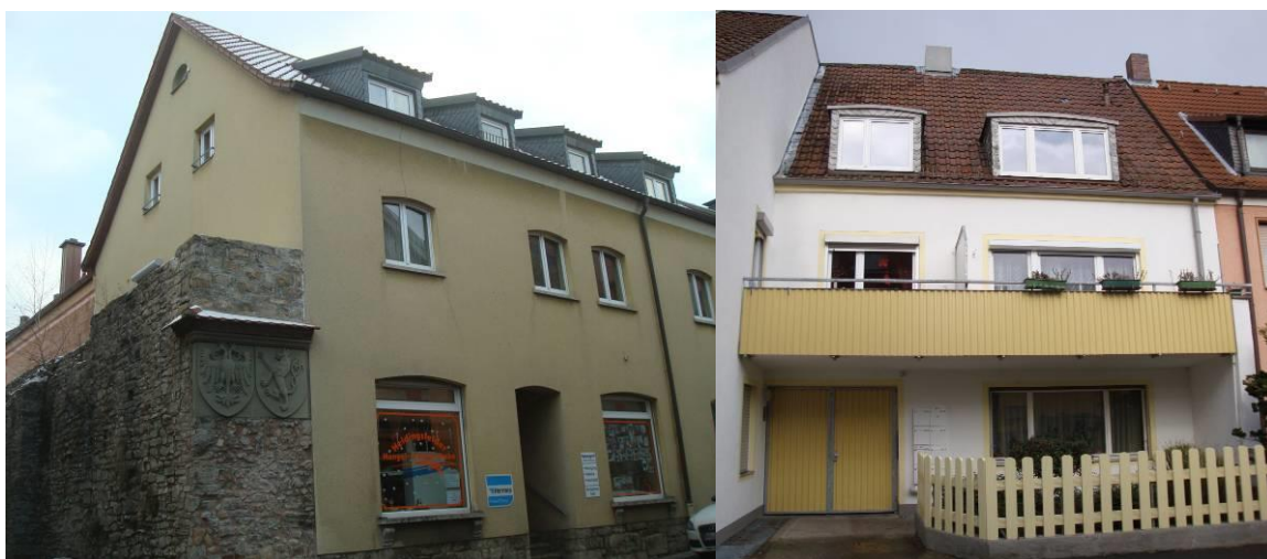
Fotoserie 6: Denkmalgeschützte Stadtmauer an Gebäude und auskragender Balkon
