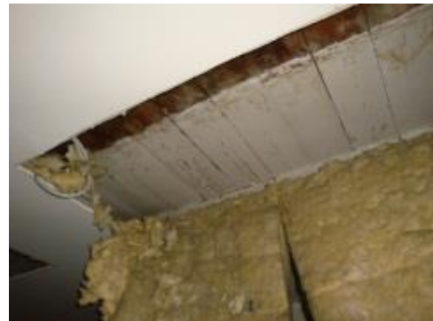
Abbildung 6 Decke Flur EG
