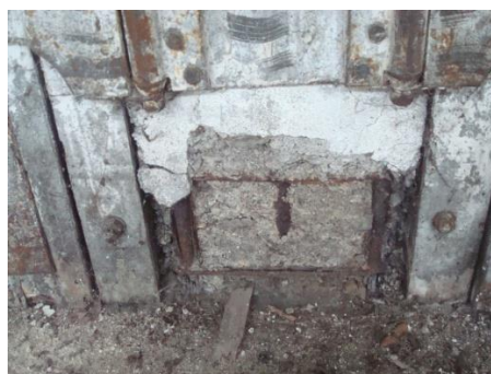
Abbildung 15 Betonkorrosion
