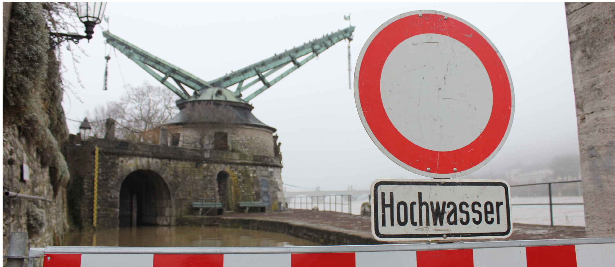
Hochwassermanagement am Kranenkai, Januar 2011
